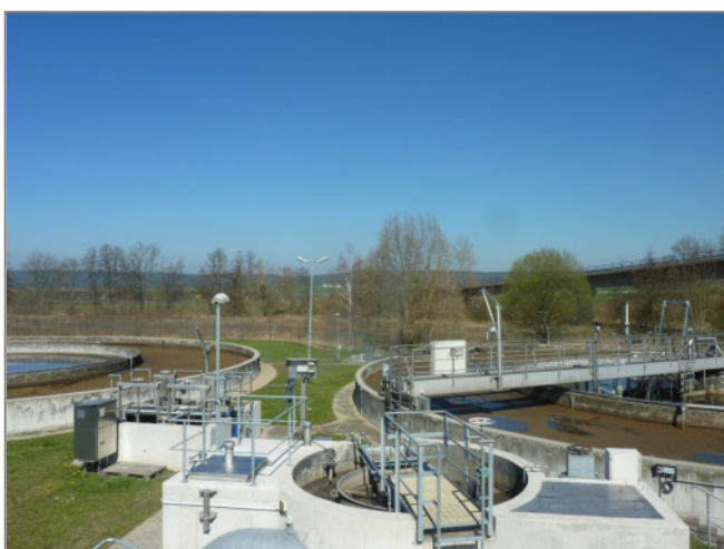
Blick auf die Kläranlage
