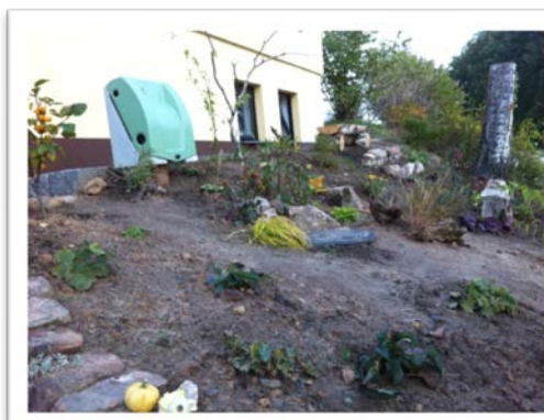
Beispiele für ungewöhnliche Standorte von Kleinkläranlagen:
